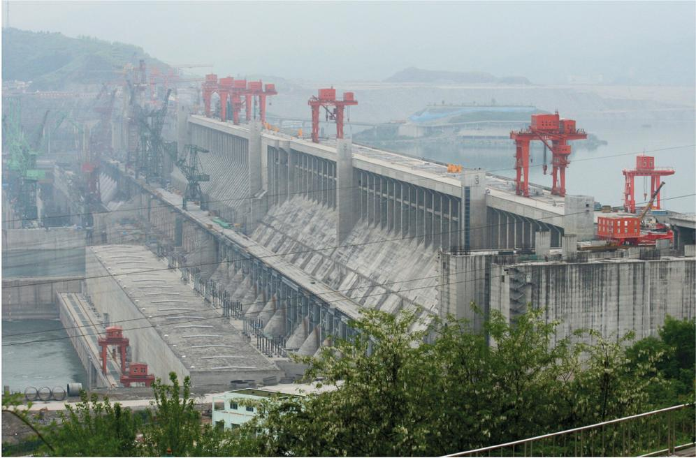
**Figure 8.3** - Barrage des Trois Gorges en Chine, mis en eau par étapes depuis 2006. Longueur : 2335 m, hauteur : 100 m, superficie de la retenue : 1080 km<sup>2</sup>, puissance installée : 18200 MW [© Christoph FILNKÖBL].
